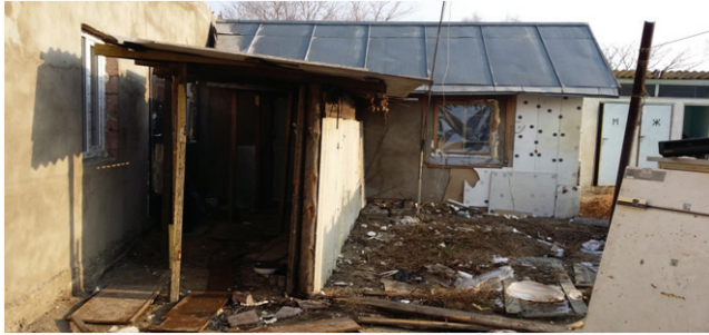
〈사진 2-10〉 건설 현장 안쪽에 있는 노동자들의 숙소와 내부
