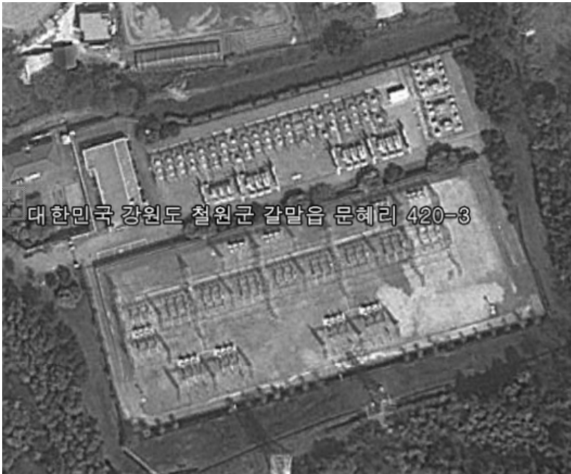
그림 IV-4 철원 154kV 변전소 전경(구글맵 참조)
