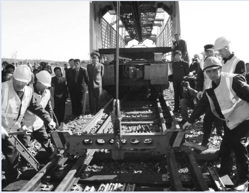
북·러 나진-햏산 철도 현대화 공사 |
