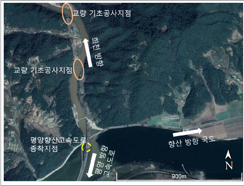
그림 III-2 평양향산고속도로의 건설 중단된 향산-희천 구간
