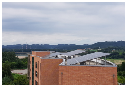
태양광 발전설비 설치(생활관 옥상)
