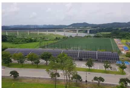
태양광 발전설비 설치(주차장)
