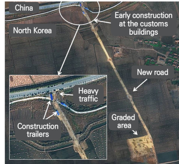
〈그림 Ⅲ-26〉 황금평경제특구 건설 현황
