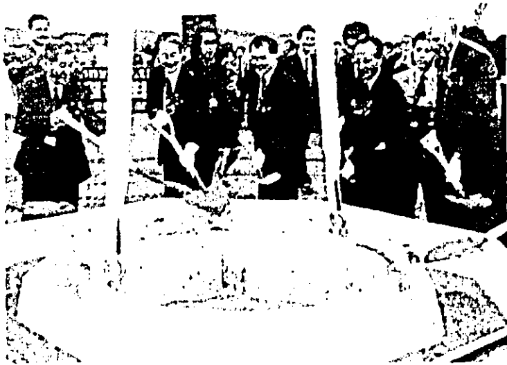
한반도에너지개발기구(KEDO) 집행이사회 관계자들이 7일 함남 금호지구 경수로 원전 1호기 공사장에서 KEDO 원전 최초의 콘크리트 기반공사 착공식을 거행하고 있다. 사진=공동취재단
