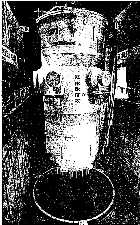
울진3호기에 설치된 한국표준형
